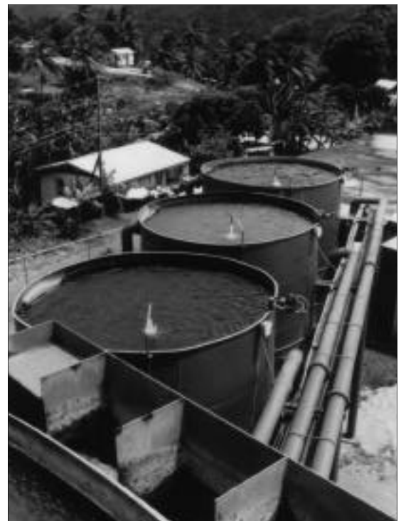
El problema de distribución de agua después de cualquier tipo de desastre natural es generalmente más serio y prolongado que el impacto visible más directo en instalaciones de salud.
