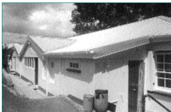
El pabellón Duncan del Hospital de St. Georges en Granada, reforzado con el proyecto de DIPECHO.
