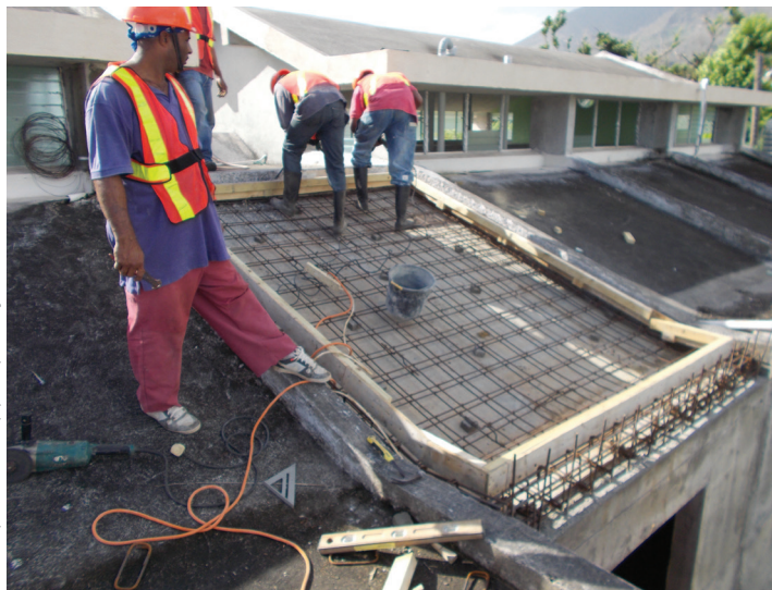
Instalación de techo de hormigón en la Clínica La Plaine en Dominica.
