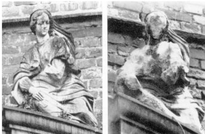
Figura 7. Deterioro acelerado en ambientes contaminados. Escultura de arenisca del Castillo de Herten, Recklinghausen, localizado en la cuenca del Rin (Alemania) y construido en 1702. Aspecto del motivo en 1908, mostrando deterioro moderado, y en 1969, prácticamente destruido. (de Winkler, 1973, Fig. 72).
