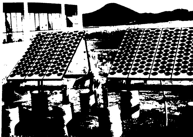
Foto B: En Perú los paneles solares están instalados cerca del suelo con un ángulo que les permite captar el máximo de luz solar. (Foto: Solar Power Corp.)
