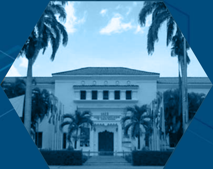
Fachada del Insituto de Altos Estudios Dr. Arnoldo Gabaldón Antigua Escuela de Malariaología y Saneamiento Ambiental. Maracay (estado Aragua)
